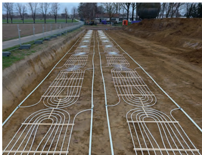
Kollektoreinbau in Bad Nauheim (© Stadtwerke Bad Nauheim)
