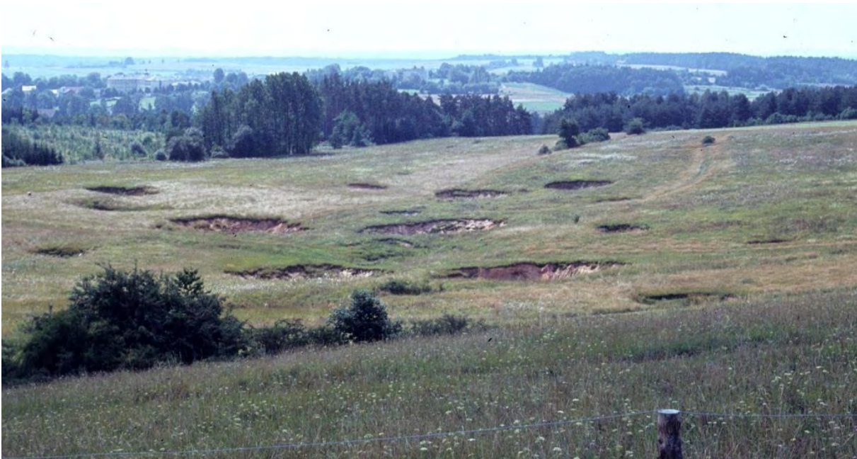
Abb.: Tagesbruchsituation über einem Erzbergbau
