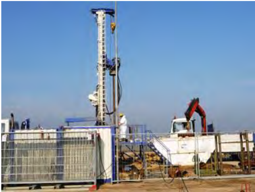
Abbildung: Pilotbohrungen Geothermie (Fraport, Terminal 3); © RP Darmstadt IV/WI-44 (Bergaufsicht)
