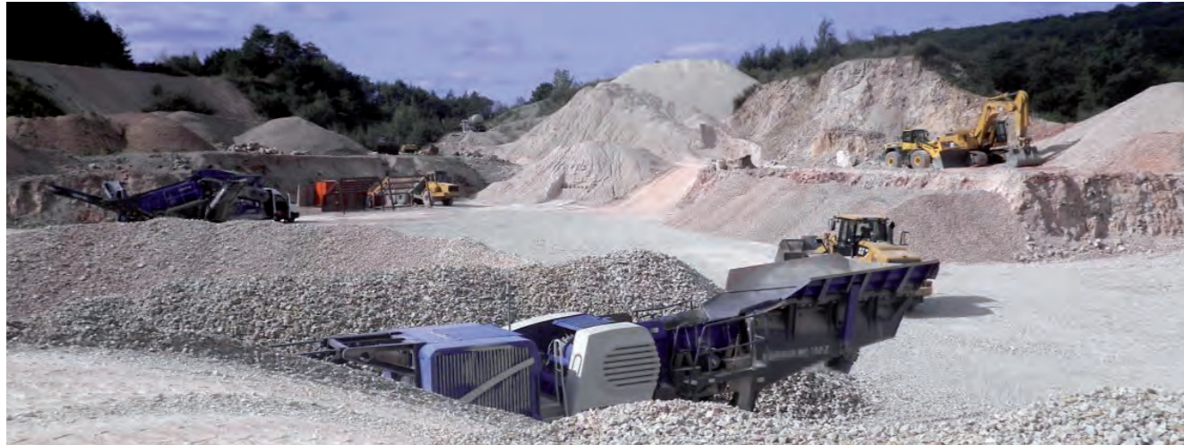
Brech- und Siebanlagen (© RP Darmstadt)
