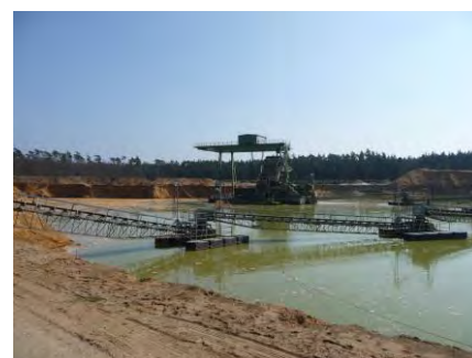
Abb. 2 Greifbagger (© RP Darmstadt)
