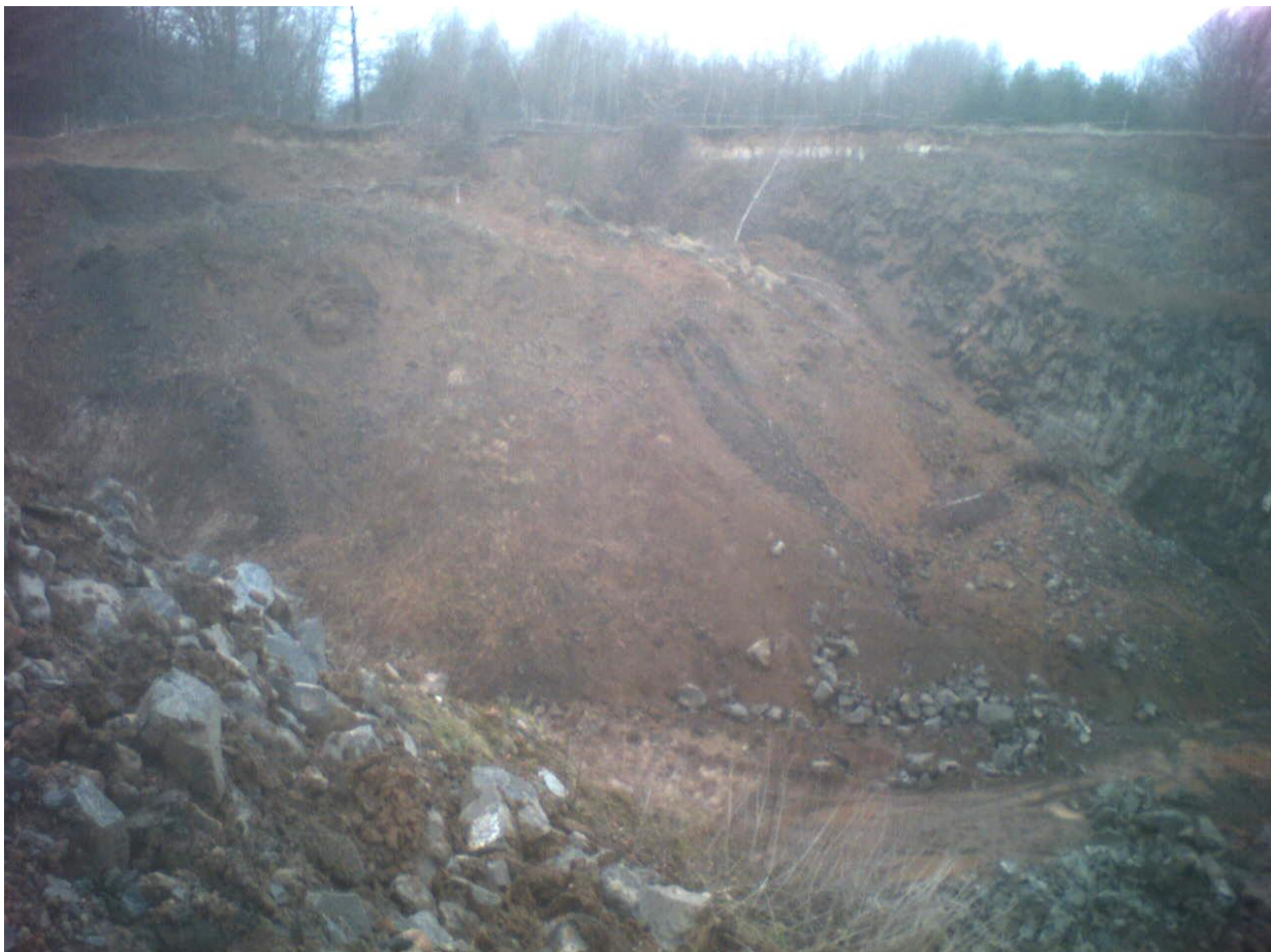
Abb.: Blick auf eine Rutschung im Tagebau
