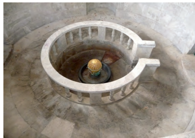
Brunnenbauwerk des Kurbrunnens in Bad Nauheim (© RP Darmstadt)
