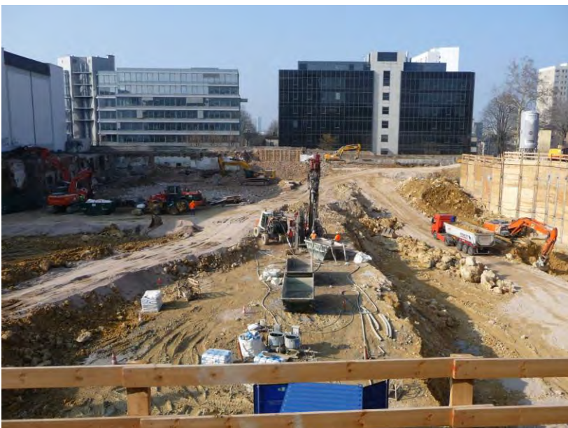
Abb.: Typische Arbeitssituation mit Bohrergerät, Spülwanne und Haspel für den Einbau der EWS; © RP Darmstadt
