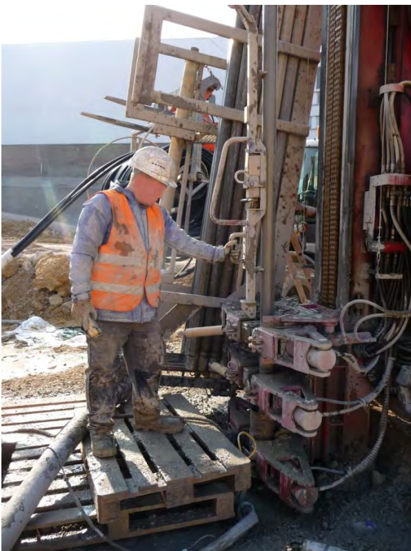
Abb.: Abteufen einer Bohrung; © RP Darmstadt
