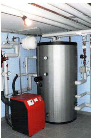
Abbildung: Heizungskeller mit Wärmepumpenanlage © [6]
