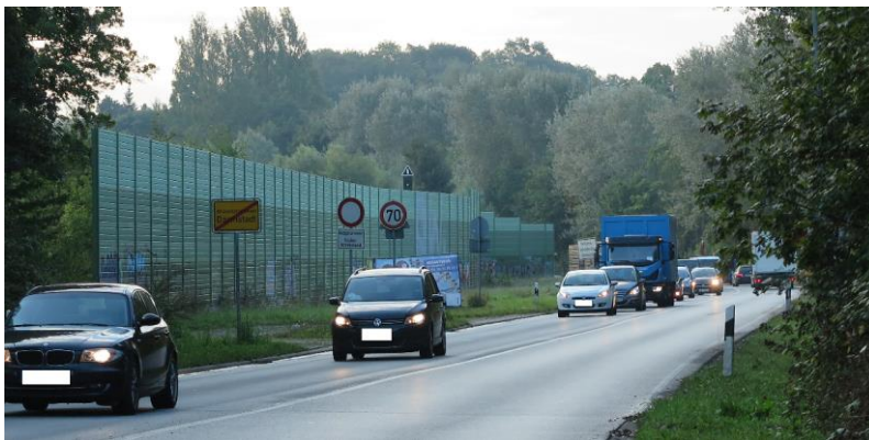
Abbildung 2: Lärmschutzwand an der B 26, Ortseingang Darmstadt 12
