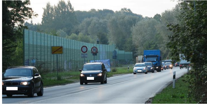
Abbildung 2: Lärmschutzwand an der B 26, Ortseingang Darmstadt © Regierungspräsidium Darmstadt
