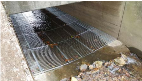
Abb. 5: Gitterrost Benthos-Pass ohne Sedimentfüllung (Blick gegen die Fließrichtung)
