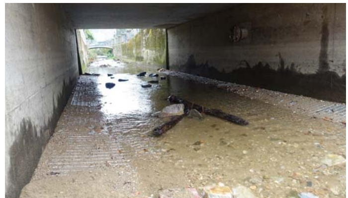
Abb. 6: Gitterrost Benthos-Pass mit Sedimentfüllung (Blick gegen die Fließrichtung)
