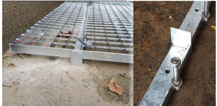
Abb. 4: Strömungsstabile befestigung der feuerverzinkten Press Gitterroste an der Brückensohle
