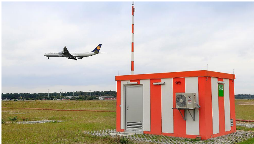
Abbildung 55: Eine GBAS-Bodenstation sendet dem Flugzeug seine genaue Position 193 © Fraport AG
