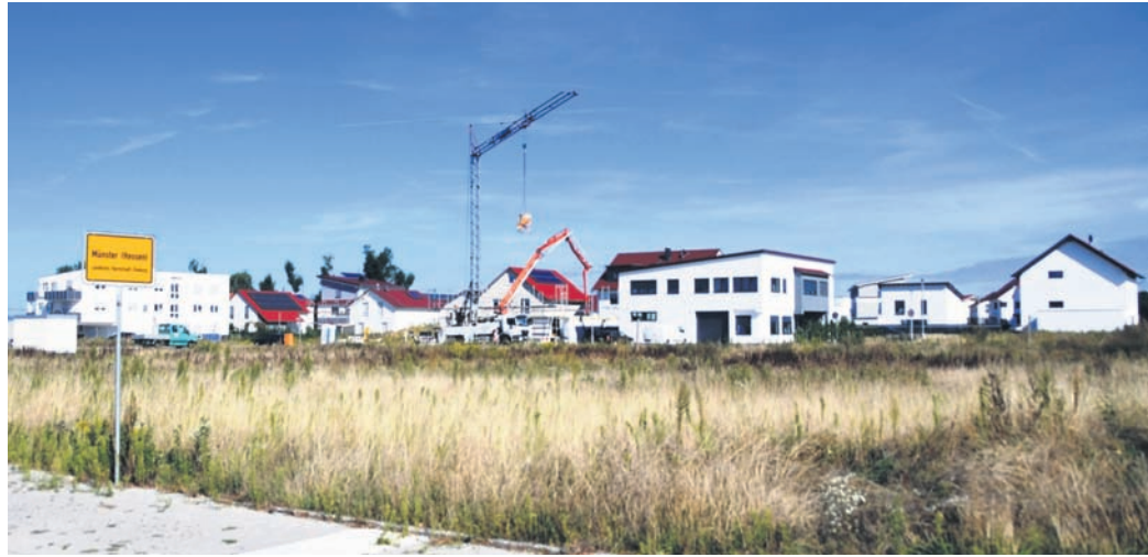
Auf dem Feldkreuz-Grundstück an der Altheimer Straße baut ein Frankfurter Investor ab Ende 2021 einen Lebensmittel-Markt, auf dem sich Wohnungen befinden - künftig allerdings nur noch 22 statt 27 Stück, weil das Gebäude nur noch 12,50 statt 15 Meter hoch werden darf. (Foto: jedö)
