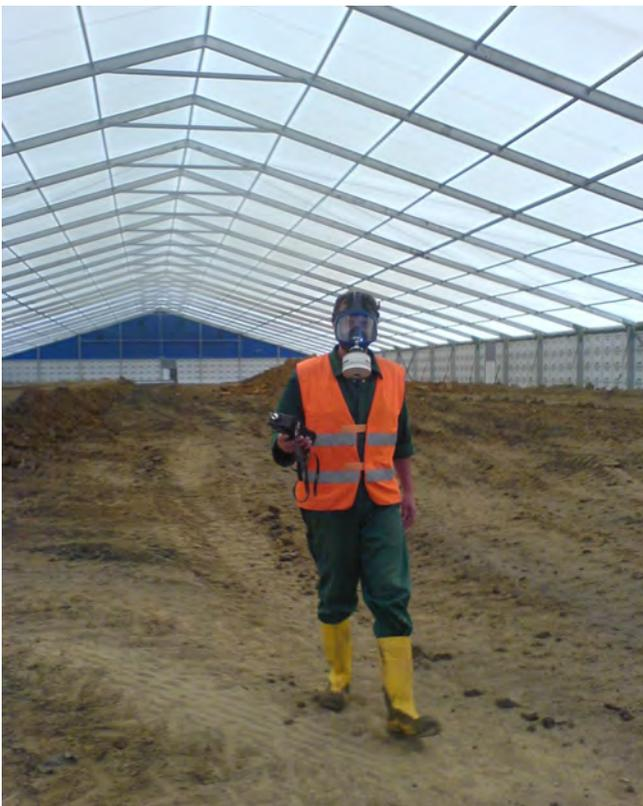
Abb. 4: Arbeiten in Schutzanzügen bei der Sanierung kontaminierter Böden
