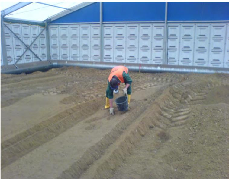
Abb. 3: Arbeiten in Schutzanzügen bei der Sanierung kontaminierter Böden
