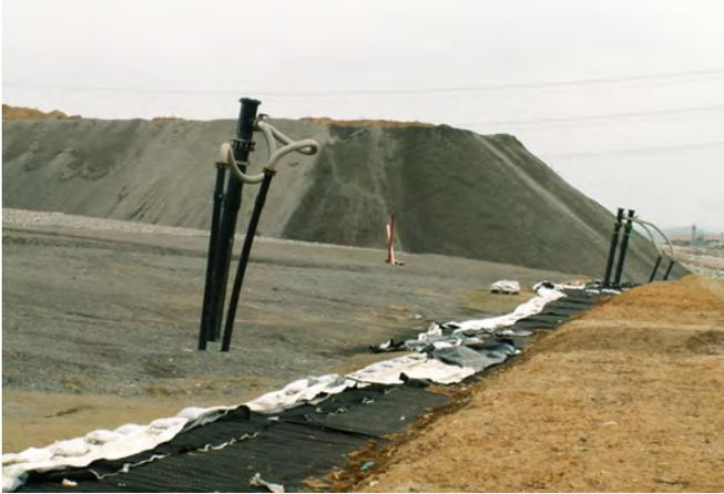
Abb. 3: Bau eines Oberflächenabdichtungssystems im Bereich von Entgasungsbrunnen (Deponie Flörsheim-Wicker, MTK)
