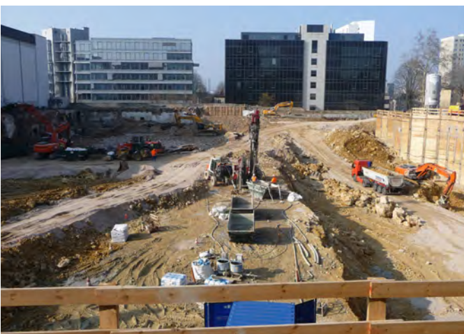
Abb.: Typische Arbeitssituation mit Bohrergerät, Spülwanne und Haspel für den Einbau der EWS; © RP Darmstadt
