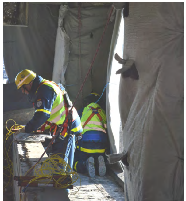
Abb.: Sprengvorbereitung mit Seilschutz; © RP Darmstadt
