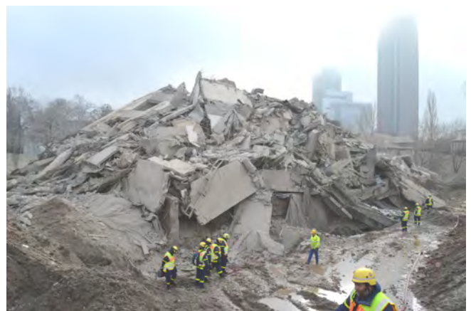
Abb.: links die 1. Sprengung von Wasserbehälter sowie Skelettbau, rechts das Sprengergebnis - ein Schutthaufen; © RP Darmstadt
