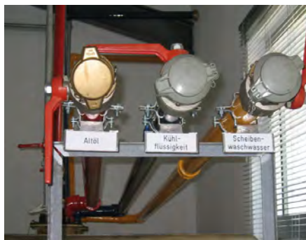
Abb.: Trockenlegung mit getrennter Lagerhaltung der Betriebsflüssigkeit; © Autoteile Ziegler, Flörsheim
