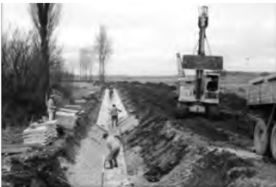
Abb.: Betonplatten waren ein Standard beim Gewässerbau in den 60er und 70er Jahren, links: am Landgraben im Hessischen Ried; rechts: auch Kunststoffplatten wurden eingesetzt; © RP Darmstadt
