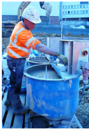
Abb. links: Während der Bohrung entnommene Bodenproben; © RP Darmstadt; rechts: Dichtemessung der Suspension; © RP Darmstadt
