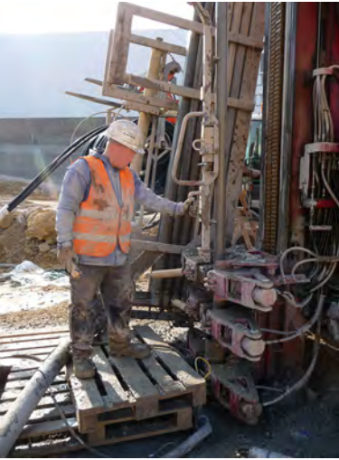
Abb.: Abteufen einer Bohrung; © RP Darmstadt
