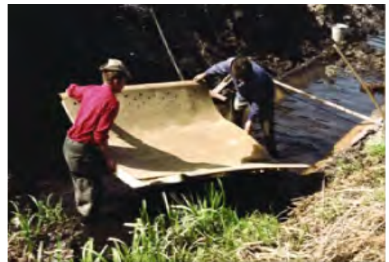
Abb.: Betonplatten waren ein Standard beim Gewässerbau in den 60er und 70er Jahren, links: am Landgraben im Hessischen Ried; rechts: auch Kunststoffplatten wurden eingesetzt; © RP Darmstadt
