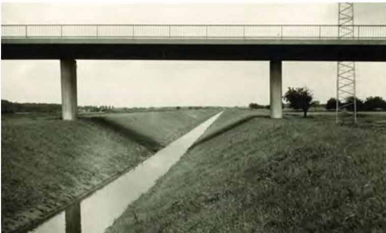
Abb.: Technischer Gewässerausbau - hier der (begradigte) Winkelbach bei Gernsheim; © RP Darmstadt
