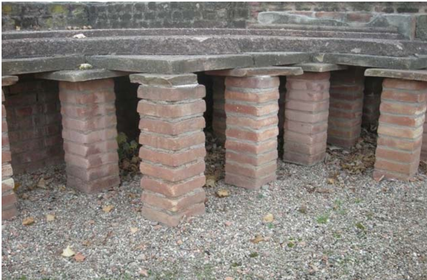
Abb. 1: „Kapitaler Holzfresser“: hypocaustum (Fußbodenheizung) der römischen villa rustica aus dem 2. Jh. n. Chr. in Höchst-Hummetroth / Odenwald (sog. Haselburg) - © RP Darmstadt
