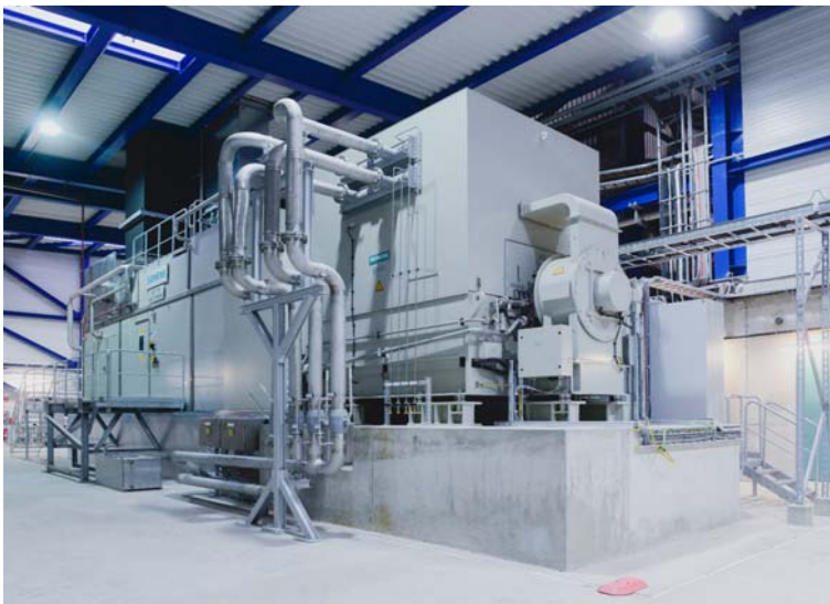
Abb. 1: Siemens-Gasturbine SGT-700 im Gas- und Dampfturbinen (GuD)-Kraftwerk der Stadtwerke Erfurt (Quelle: "www.siemens.com/presse")
