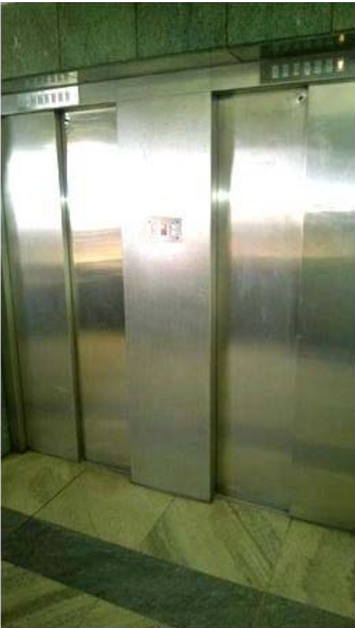
Abb. 1: Zwei Fahrkörbe in einem gemeinsamen Aufzugsschacht - © RP Darmstadt
