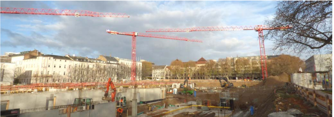
Abb. 4: Baustelle Rhein-Main-Hallen November 2015 (© RP Darmstadt)
