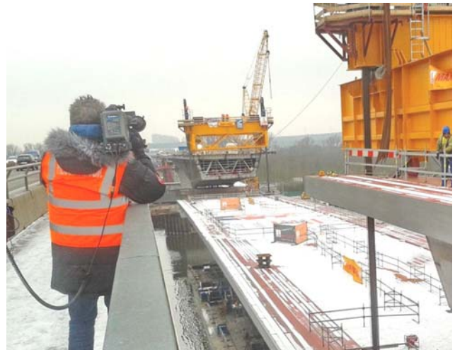
Abb. 2: Anheben und Positionieren des neuen Brückenteils, Januar 2016 (© RP Darmstadt)
