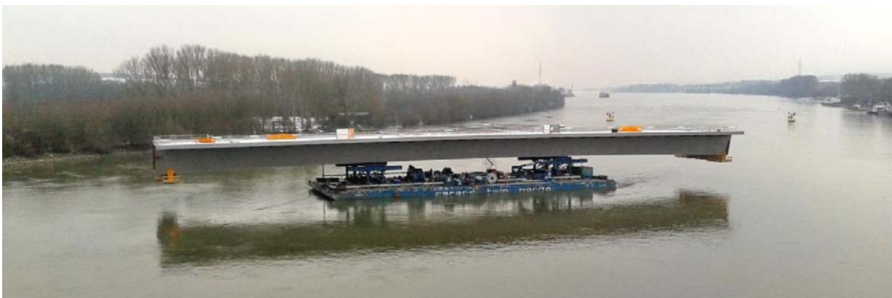
Abb. 1: Einschwimmen neues Brückenteil Januar 2016 (© RP Darmstadt)
