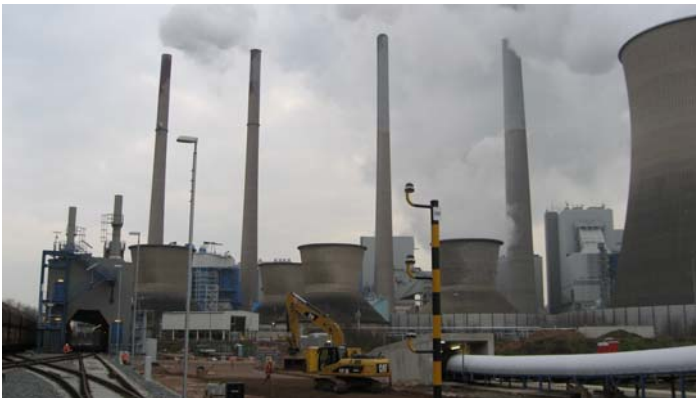
Abb. 1: Kraftwerk Staudinger 2009 - noch mit fünf Blöcken unter Dampf (© RP Darmstadt)
