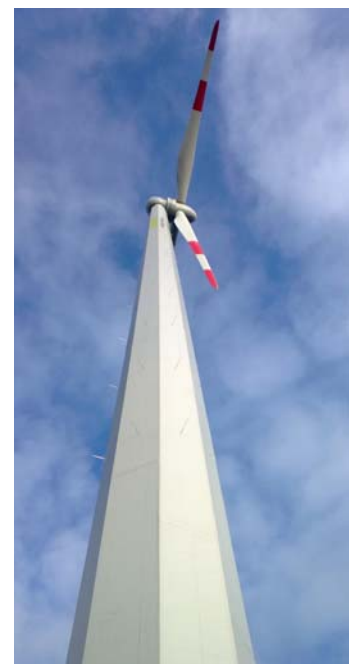
Abb. 1: Der erste Holzturm für Windkraftanlagen (© Fa. TiComTec, 2012)
