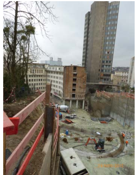
Abb. 5: Baustelle Kureck November 2015 (© RP Darmstadt)
