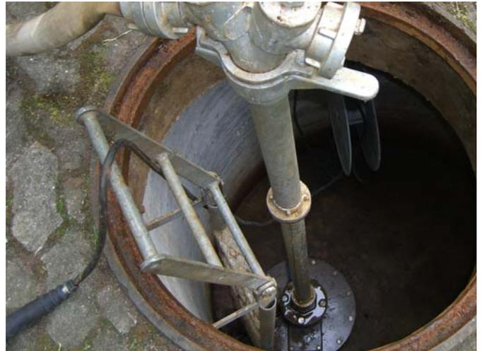
Abb. 1: Notbrunnenschacht mit aufgesetzten Standrohr (© RP Darmstadt)
