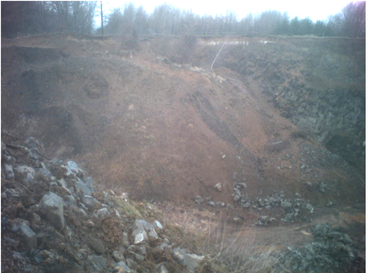
Abb.: Blick auf eine Rutschung im Tagebau
