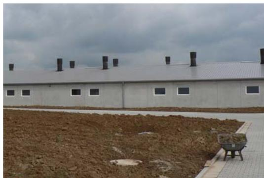
Abb. 2: Stall mit Ablufführung über gefasste Quellen (im Bild 8 Kamine)
