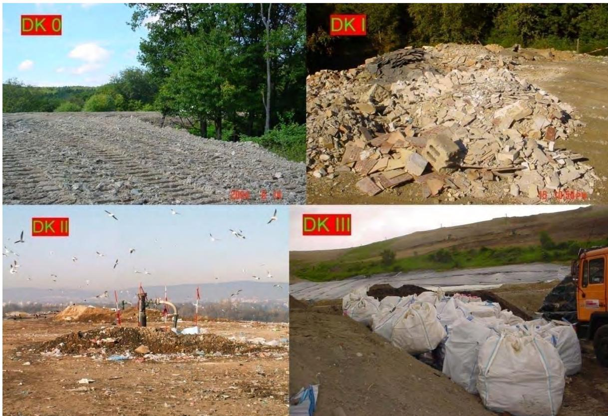
Unterschiedliche Deponietypen (Deponieklassen „DK 0“ bis „DK III“; „DK IV“ ohne Abb.)
