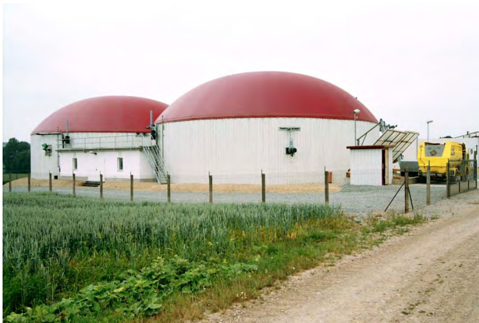
Abb.: Biogasanlage (Blick auf 2 Fermenter mit Pump- und Steuerhaus); © JuwelTop / pixelio.de
