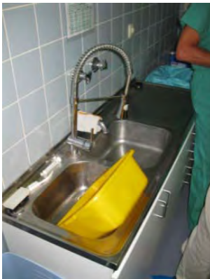
Abb. 2: Die Desinfektion findet unsachgemäß in der zu sehenden gelben Plastikwanne statt.
