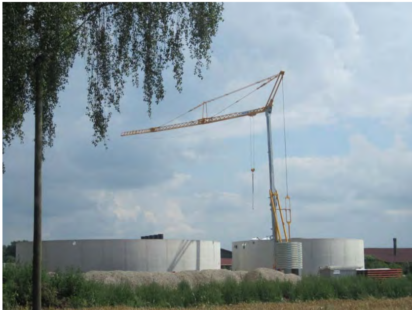
Abb.: Baustelle einer Biogasanlage; © Wilhelmine Wulff / pixelio.de
