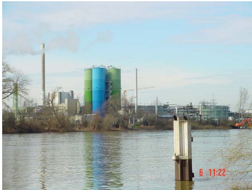
Anaerob-Reaktoren einer biologischen Abwasserreinigungsanlage am Rhein
