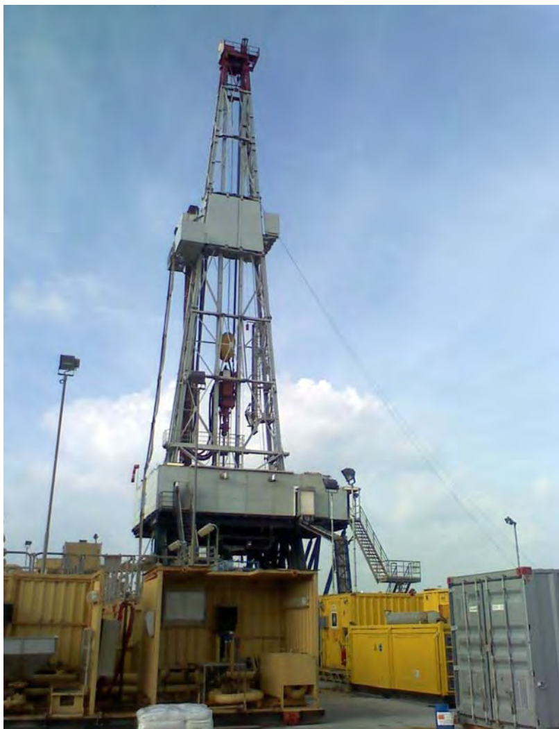
Bild: Bohrturm einer Erdwärmebohrung
