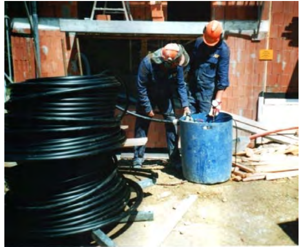
Bild 2: Sondendruckprüfung im Wassereimer vor Ort
