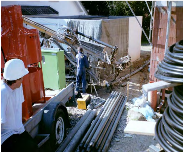
Bild1: Einrichtung der Bohrstelle
