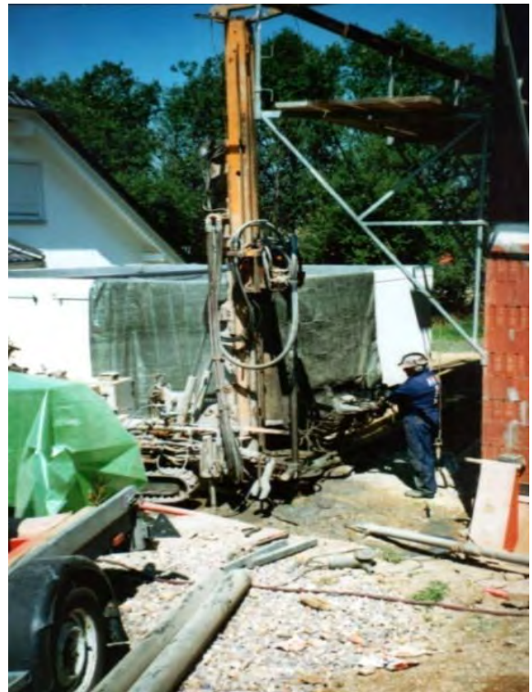
Bild: Die Erdwärmebohrarbeiten in unserem ‚Vorgarten‘
