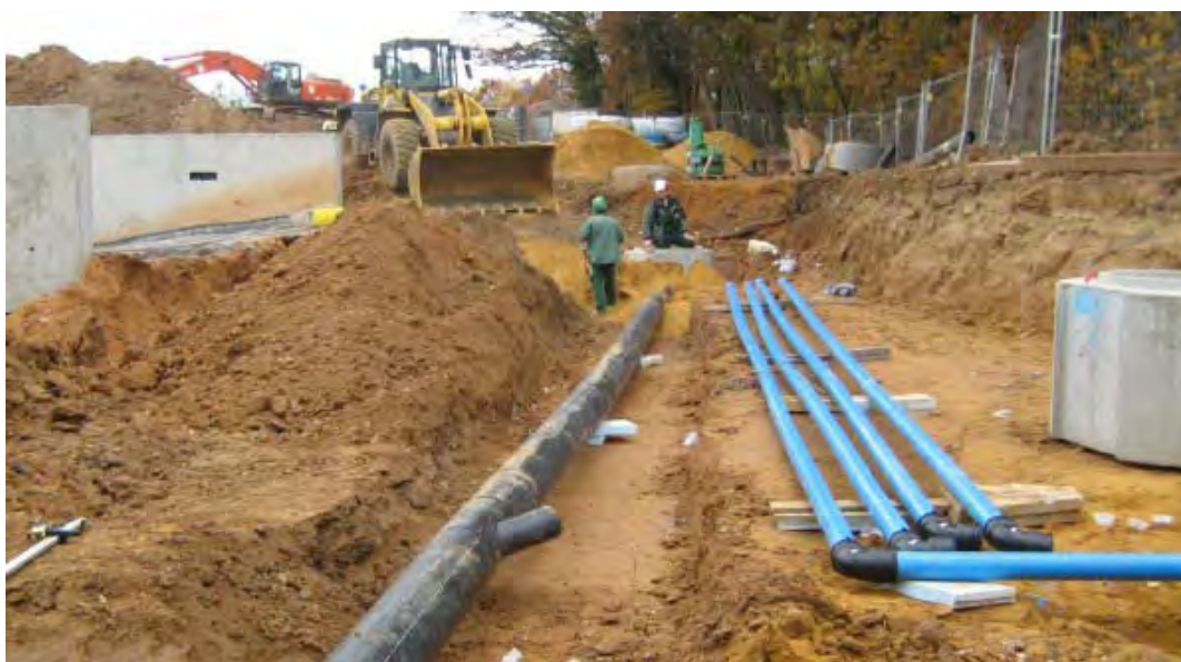
Bild: Horizontale Anbindung von Erdwärmesonden (Friedrichsdorf, Hochtaunuskreis)
