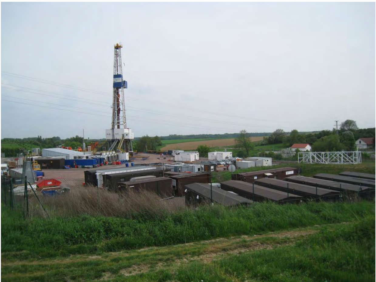
Bild 4: Bohrplatz einer Tiefbohrung
