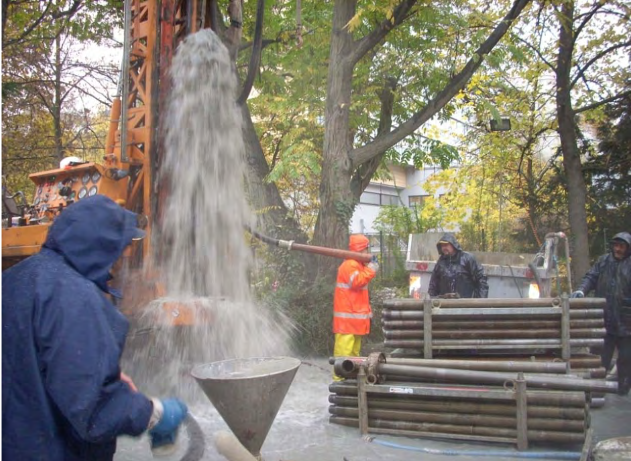
Bild 1: Die Verpressung wird vorbereitet
