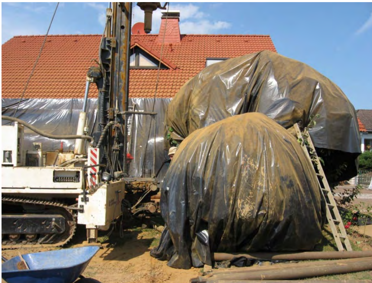
Bild: Erdwärmebohrung, hier mit Vegetationsschutz
