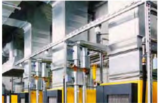
Bild: Rückgewinnung der Kompressorwärme zur Raumheizung
