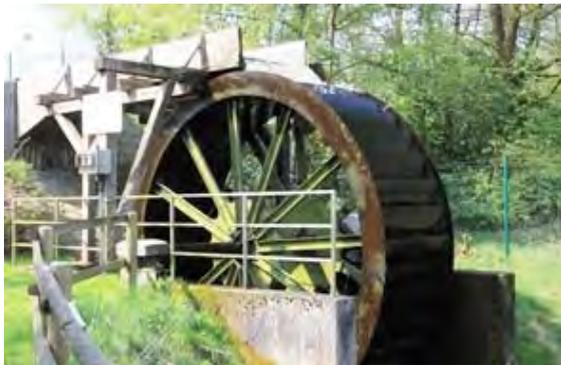
**Bild: Kläranlagen-Auslaufbauwerk mit Wasserrad**
