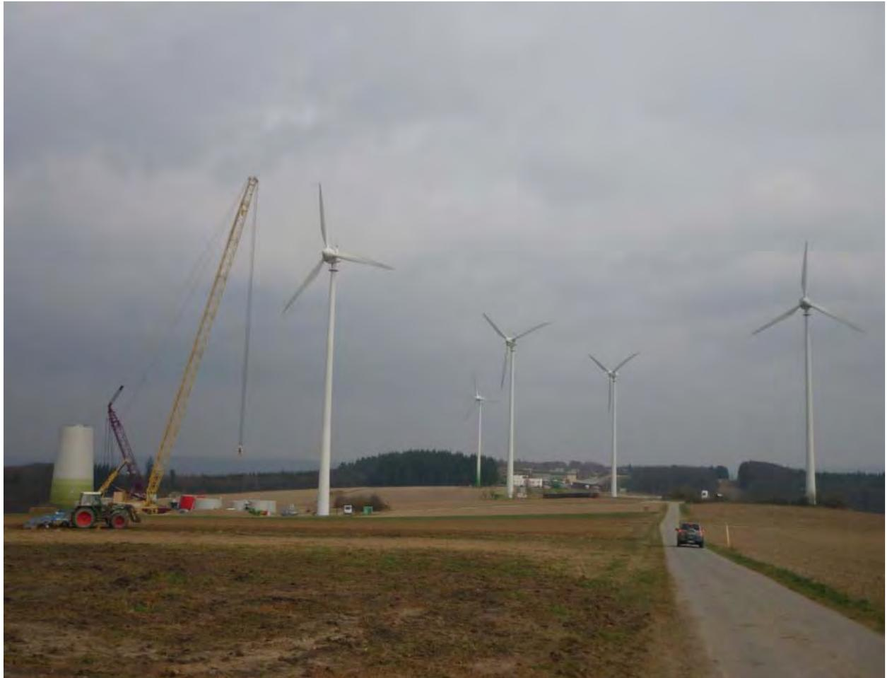
**Bild: „Beispiel Repowering“ - Ersatz einer WKA mit einer Gesamthöhe von ca. 90 m und 500 KW Nennleistung durch eine WKA mit einer Gesamthöhe von ca. 180 m und 2,3 MW Nennleistung (ca. 4-5 fache Leistung)**
