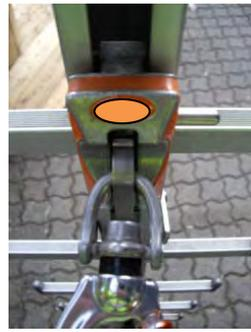
Bild: Läufer in der Steigschutzschiene
