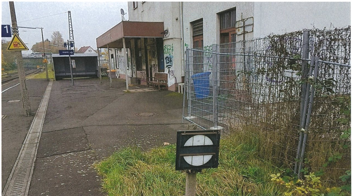
Abb.3: Wartehäuschen, das abgerissen werden soll
