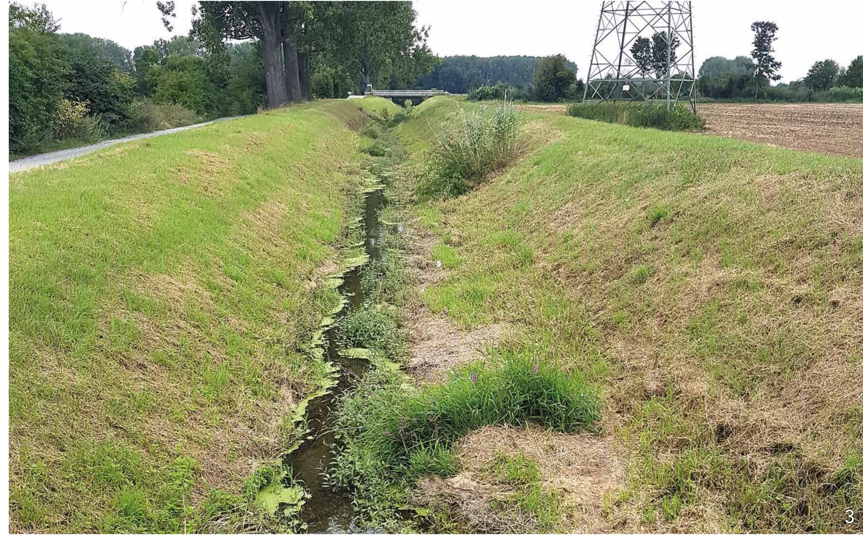
Der Schwalbenzahlgraben wird unter ökologischen Gesichtspunkten unterhalten: Durch wechselseitige Mahd wird ein pendelnder Stromstich erreicht, dies fördert die Artenvielfalt.
