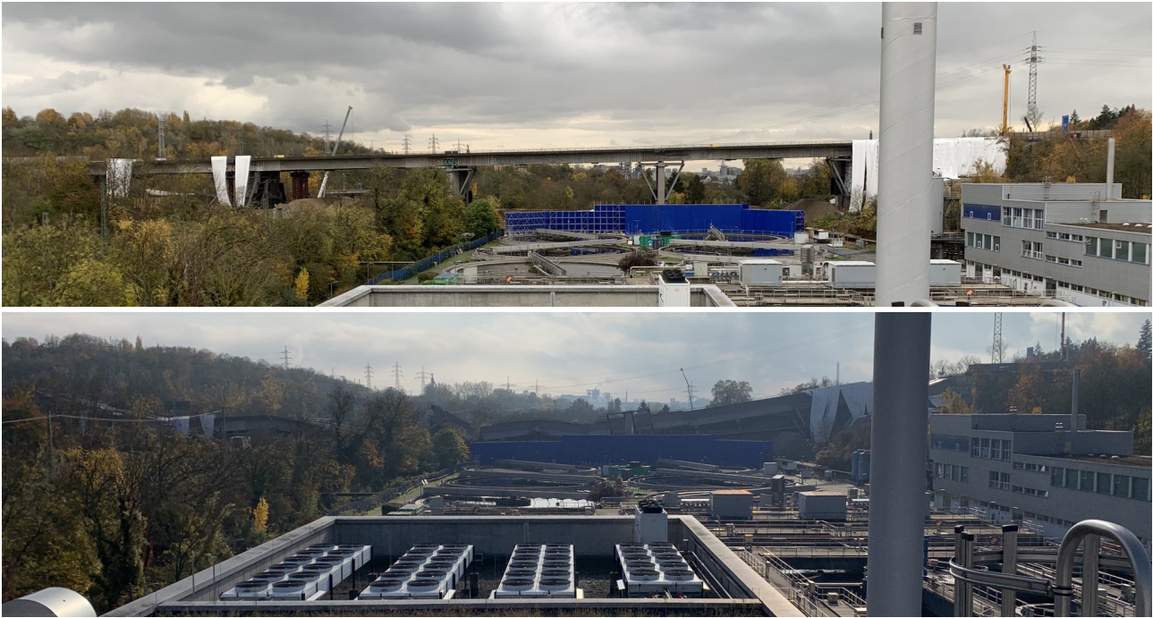
Ansicht vor (oben) und nach (unten) der Sprengung: Im Vordergrund die Nachklärbecken, dahinter die blauen Streuschutzmatten © Frank Fischer, „Stabstelle Unternehmenskommunikation“ der Entsorgungsbetriebe der Landeshauptstadt Wiesbaden
