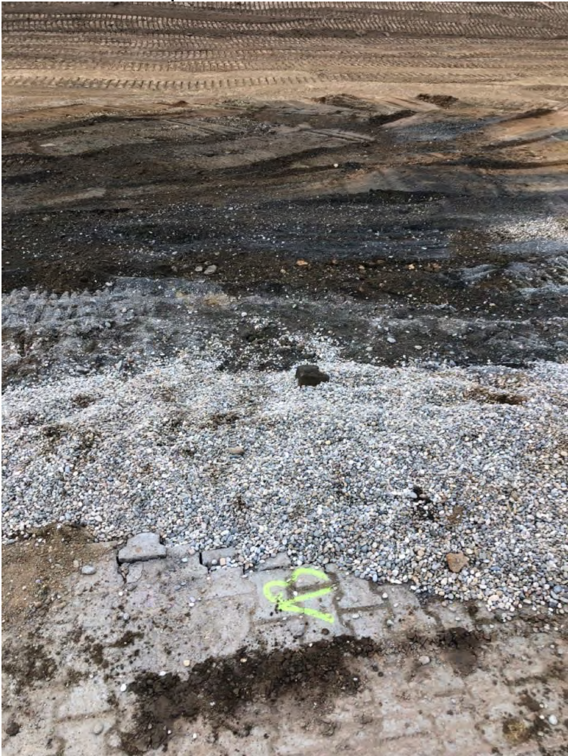
Bohransatzpunkt KRB/DPH 13 nach dem Verschließen
