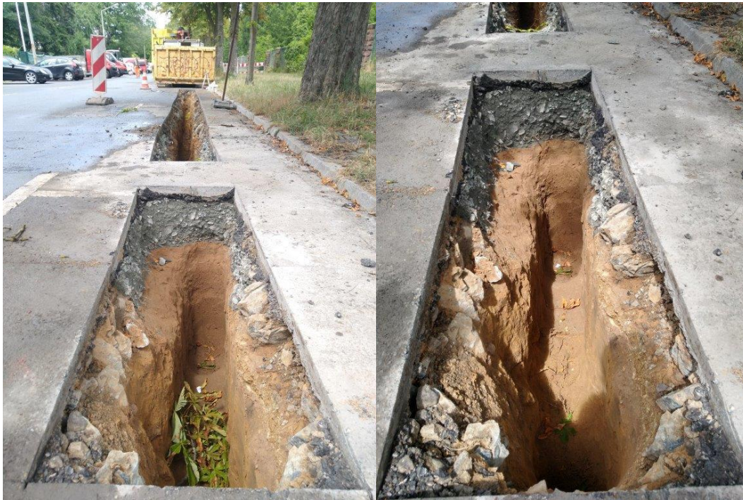
Abbildung 10: Straßenseitiger Wurzelsuchgraben an den Bäumen 9 und 10; links: Übersichtsbild Graben, rechts im Bild Stamm von Baum 9, weiter hinten im Bild Stamm von Baum 10 (Jungbaum); rechts: Detailaufnahme erster Grabenabschnitt, keine Wurzelfunde
