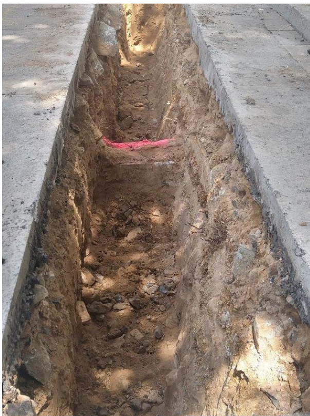
Abbildung 19: Suchgraben und Starkwurzelfund an Rosskastanie 41
