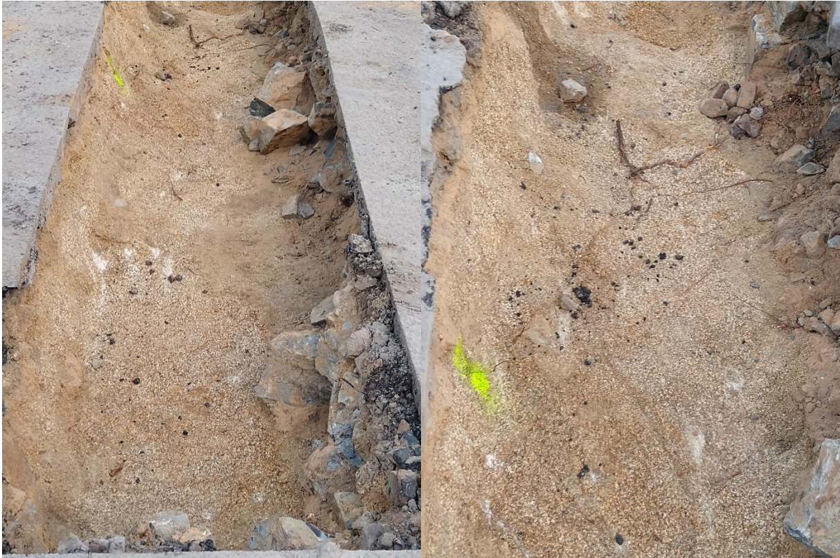
Abbildung 9: Suchgraben an Rosskastanie 2, links: Übersichtsbild, rechts: Detailaufnahme gelb markierter Schwachwurzelsfund
