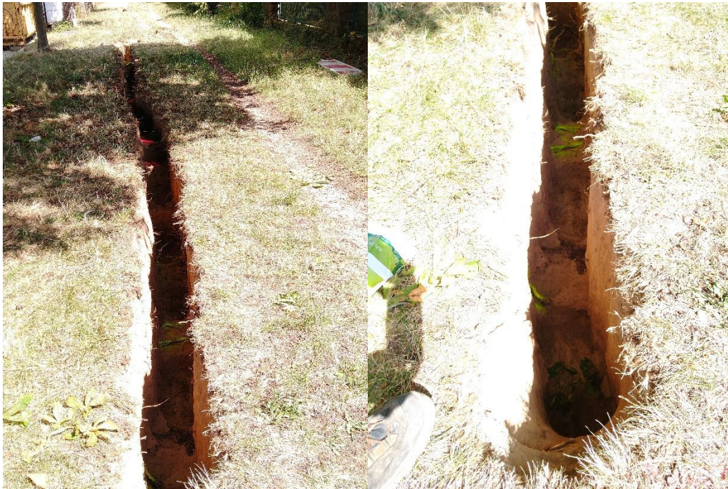
Abbildung 12: Gehwegseitiger Wurzelsuchgraben an Baum 9 und 10, links: Übersichtsbild, hinten links im Bild Stamm von Baum 10; rechts: Schwachwurzelfunde im ersten Grabenabschnitt, Baum 9 zuzuordnen
