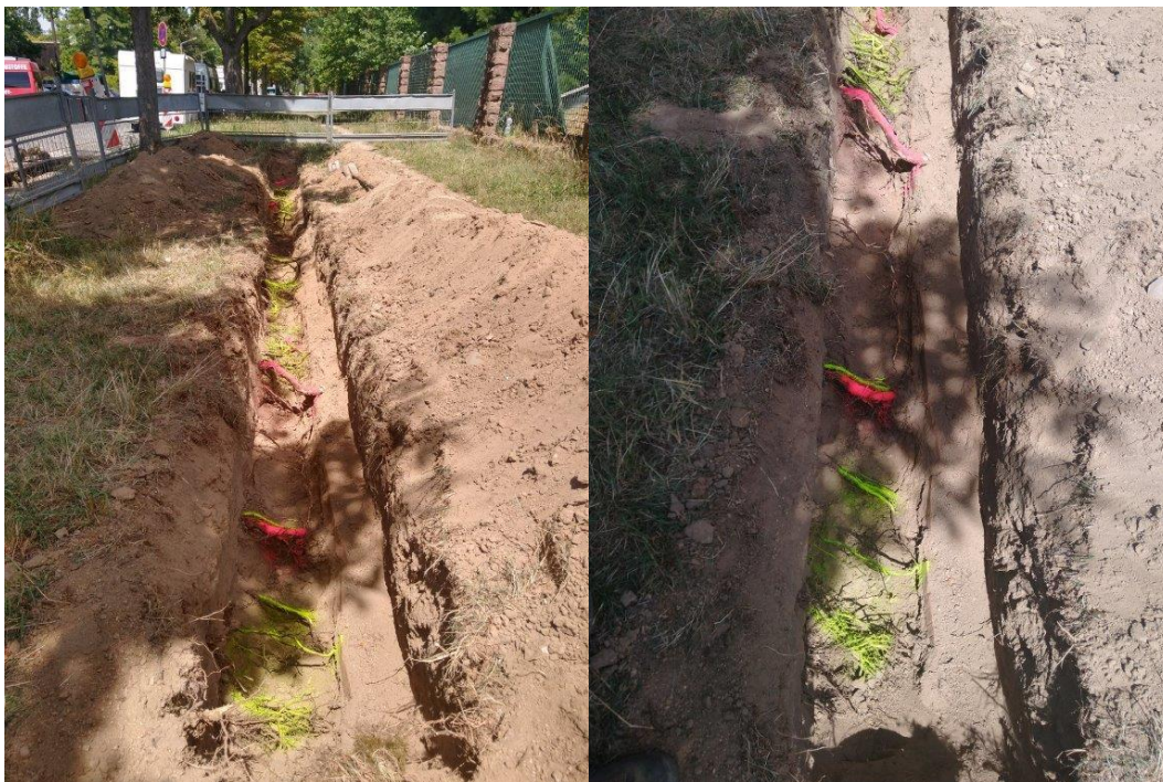
Abbildung 17: Gehwegseitige Wurzelsuchgrabung an Rosskastanie 16; links: Übersichtsbild Suchgraben; rechts: Detailaufnahme Wurzelfunde
