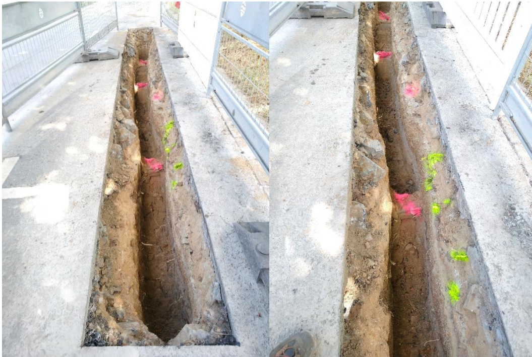
Abbildung 14: Straßenseitiger Wurzelsuchgraben an Rosskastanie 13; links: Übersichtsbild; rechts: Detailaufnahme Wurzelfunde (Grob- und Starkwurzeln rot markiert)
