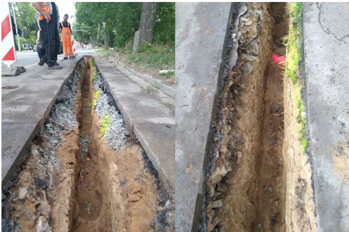
Abbildung 18: Suchgrabung an Platane 36; links: Übersichtsbild; rechts: Detailaufnahme Starkwurzelfund (rot markiert) und oberflächennahe Feinst- und Feinwurzeln (gelb markiert)
