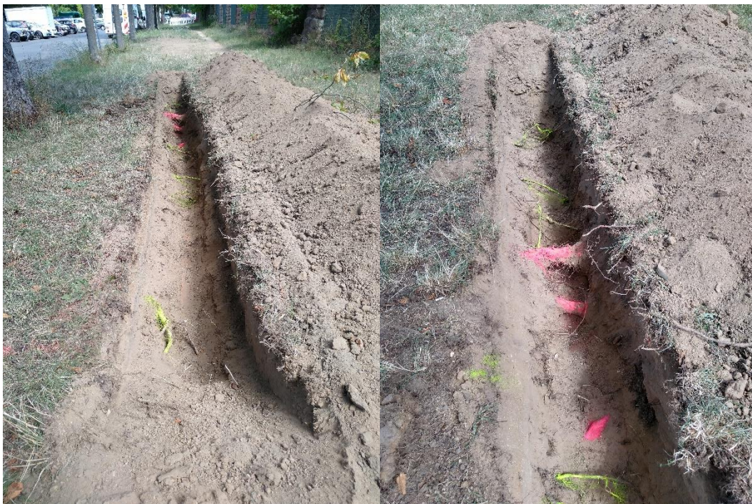
Abbildung 15: Gehwegseitiger Wurzelsuchgraben an Rosskastanie 13; links: Übersichtsbild, rechts: Detailaufnahme Starkwurzelfunde (rot markiert)
