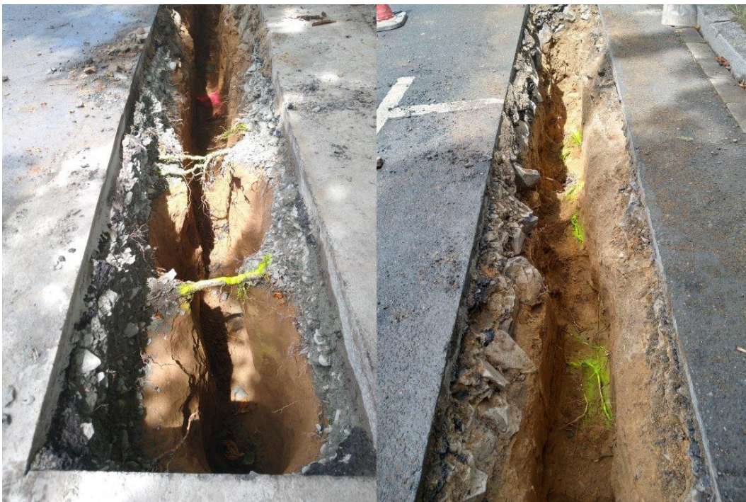
Abbildung 11: Straßenseitiger Wurzelsuchgraben an den Bäumen 9 und 10; links: Wurzelfunde im Bereich von Baum 9, Starkwurzel rot markiert; rechts: Wurzelfunde im Bereich von Baum 10
