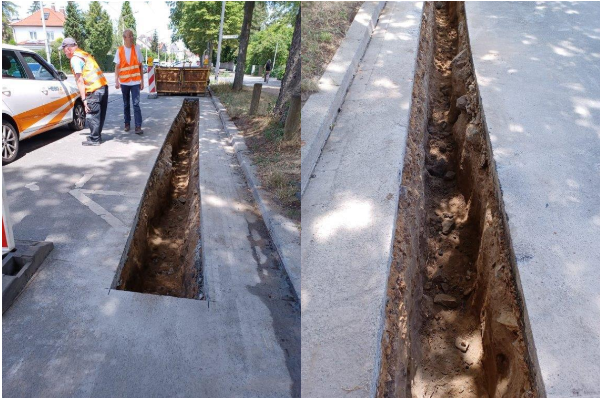
Abbildung 20: Suchgraben an veredelter Kastanie 44 ohne Wurzelfunde; links: Übersichtsbild; rechts: Detailaufnahme
