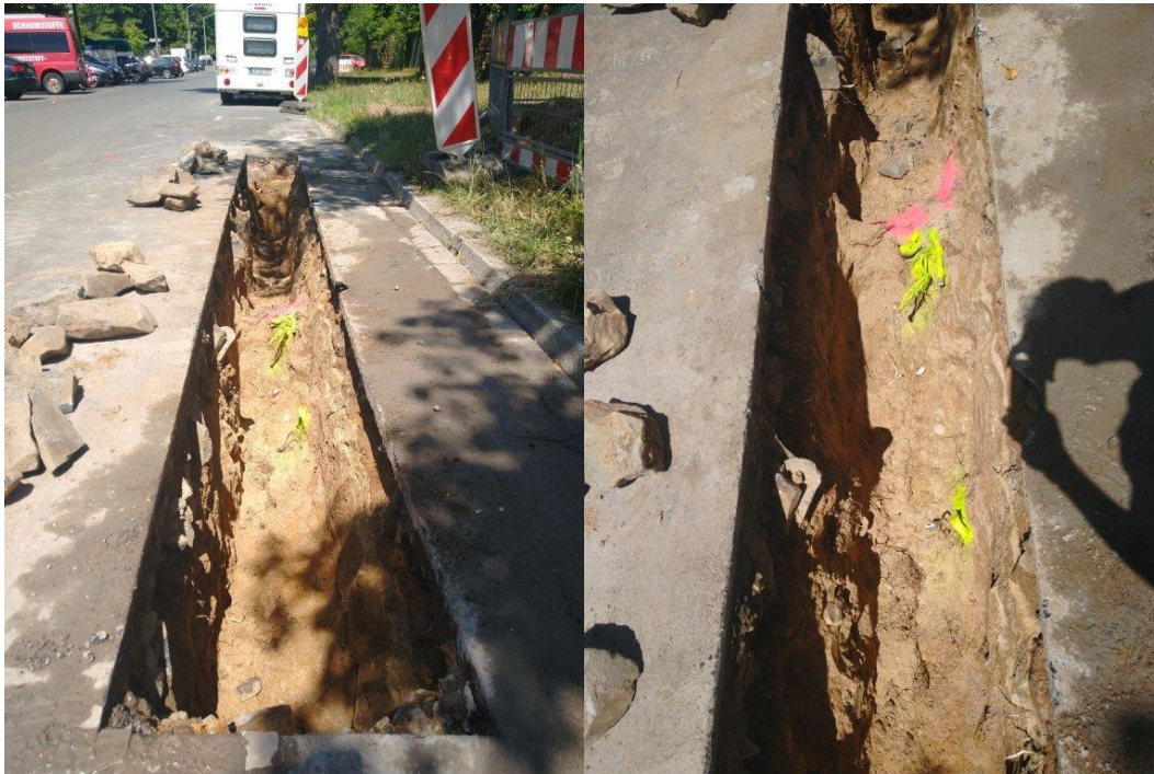
Abbildung 16: Straßenseitige Wurzelsuchgrabung an Rosskastanie 16; links: Übersichtsbild Suchgraben; rechts: Detailaufnahme Wurzelfunde, hier ausnahmsweise nur die Starkwurzel rot markiert und die 3 Grobwurzeln gelb markiert
