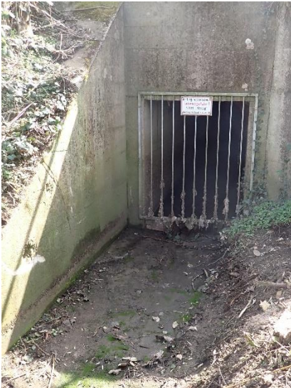
Abbildung 3-5: Fotostandorte F bis G (Kartengrundlage /6/); F1: Mündung Regenwassertunnel der Straßenentwässerung entlang Ladestraße diagonal gegenüber Bahnhof Hailer-Meerholz, F2: vergitterter Auslass, F3: Blick in den Tunnel; G1: Pumpstation Meerholz/Hailer des Abwasserverbandes Freigericht, G2: Auslassrohr der Pumpstation
