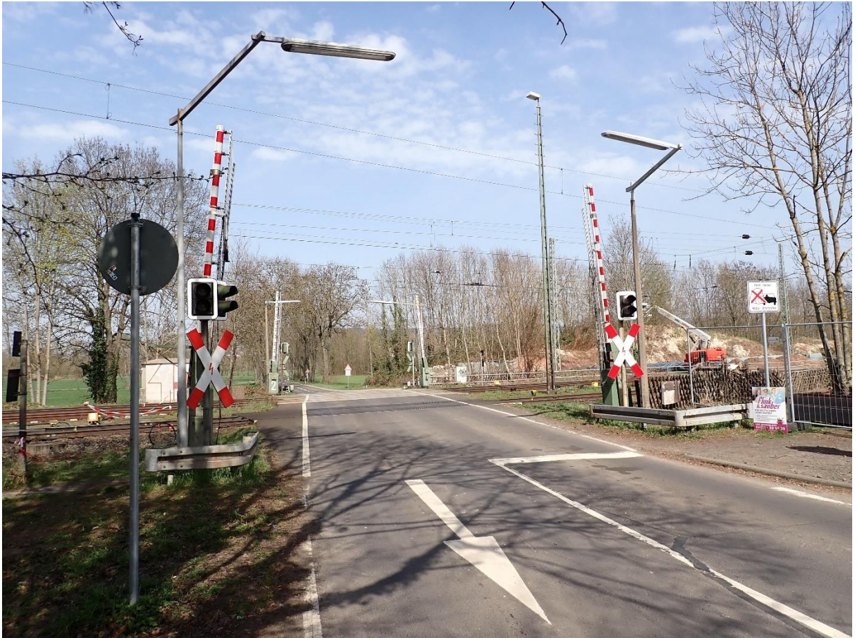
Abbildung 3-2: Geländesituation am höhengleichen Bahnübergang der K 904 am Ortsausgang von Hailer, Blickrichtung Norden, Foto BGD ECOSAX vom 01.04.2021
