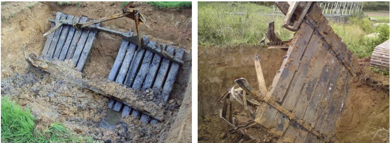
Das Schwellenfundament wird innerhalb der Baugrube zerlegt, Holzschwellen und Gestänge werden hierbei voneinander getrennt und separat in Container verladen.
