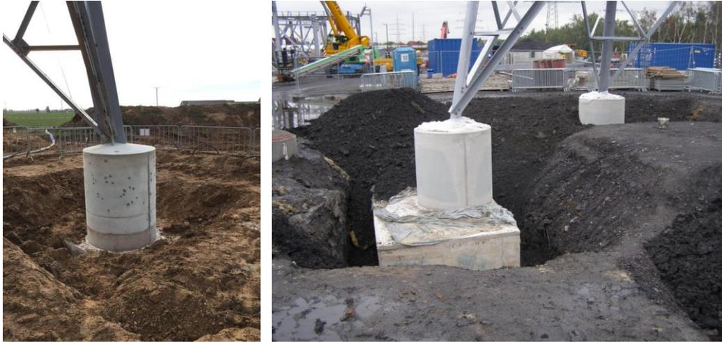
Unmittelbar nach der Erstellung der Fundamentköpfe wird die Baugrube entsprechend der vorgefundenen Bodenschichten wieder verfüllt. Nach Abschluss der Verfüllung der Baugrube sind sämtliche Tiefbauarbeiten für die Errichtung des neuen Freileitungsmastes abgeschlossen (siehe Abbildung 11).
