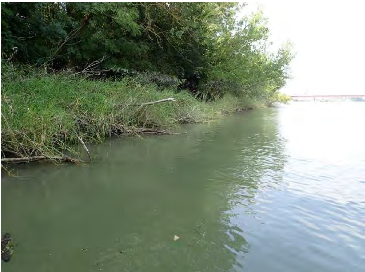
Abbildung 2-8: Ginsheimer Altrhein, Mündungsbereich. Die Blockschüttung war fast vollständig überstaut (Foto 2021).
