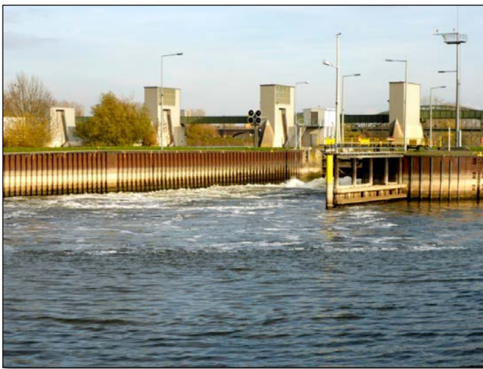
Abb. 20a: Auslaufbereich der rechten Schiffsschleusenkammer Staustufe Kostheim beim Öffnen des Schützes (November 2015).
