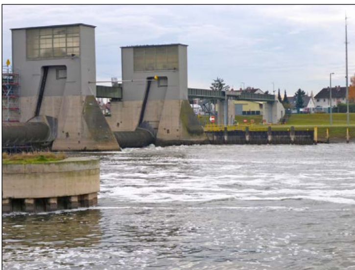
Abb. 20b: Angehobene Wehrwalze (um 62 cm) auf der linken Uferseite; Durchfluss 118 m 3 /s (22.11.2016).
