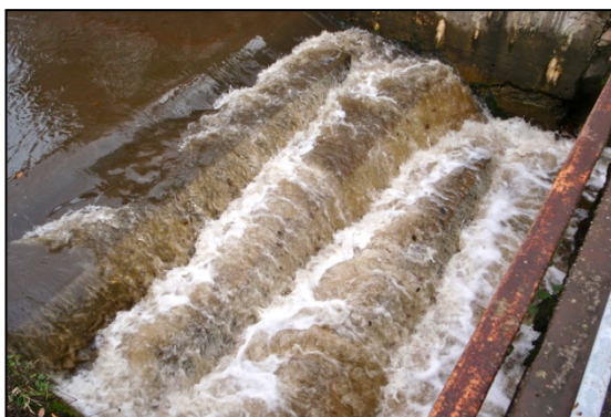
Rampe Schlaadt bei hohem Abfluss am 12.11.2010
